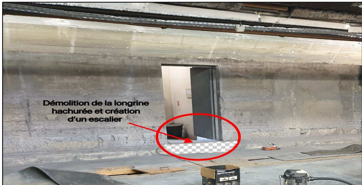
Figure 4. Démolition de la longrine hachurée à l'extérieur de la rentrée et création d'un escalier
