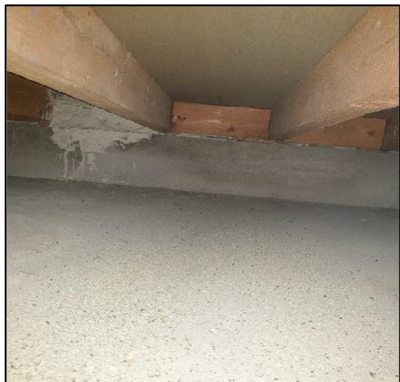
Figure 8. Vue du sondage destructif du plancher en bois avec des solives.
