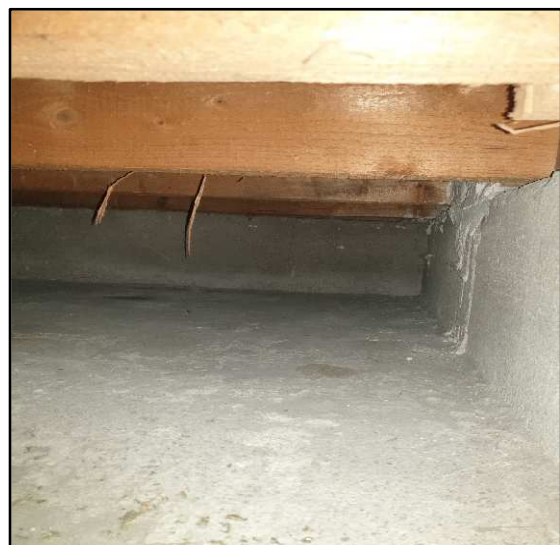
Figure 8. Vue du sondage destructif du plancher en bois avec des solives.
