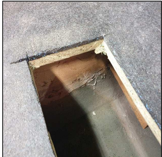
Figure 7. Vue du sondage destructif du plancher bas du RDC.
