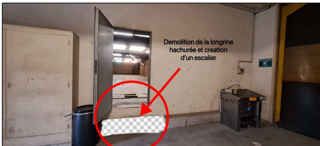
Figure 5. Démolition de la longrine hachurée à l'intérieur de la rentrée et création d'un escalier
