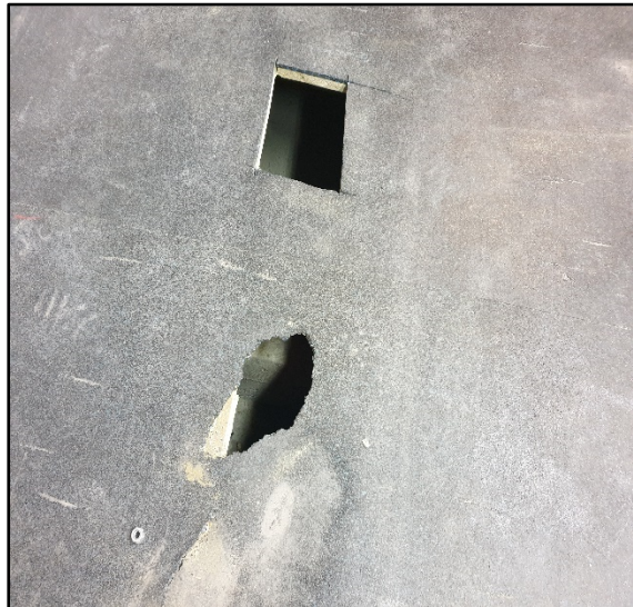
Figure 7. Vue du sondage destructif du plancher bas du RDC.
